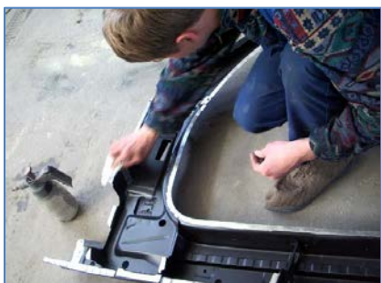
Pilt 50: Haljad liimitavad pinnad puhastatakse eelpuhastusvahendiga.
