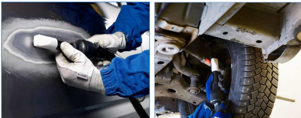
Pilt 74, 75: Induksioonkuumutiga plekipinna ja kinni jäänud keermesliidete kuumutamine
