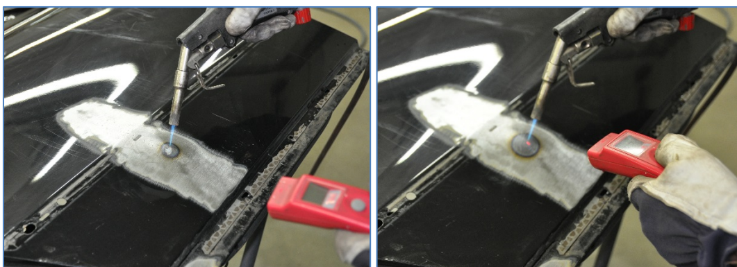
Pilt 76, 77: pinna kuumutamine gaasipõletiga ja pinnatemperatuuri kontroll IR-termomeetri abil.
