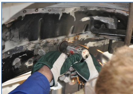
Pilt 66: Korkkeevituse mahalihvimine mini-nurklihvija ja roloc-kettaga.
